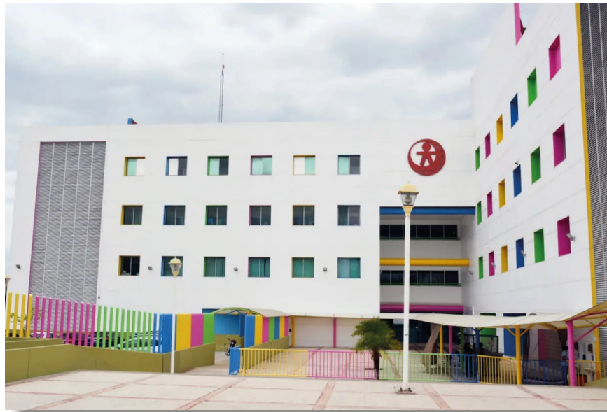
Hospital de Especialidades Pediátricas de Tuxtla Gutiérrez
