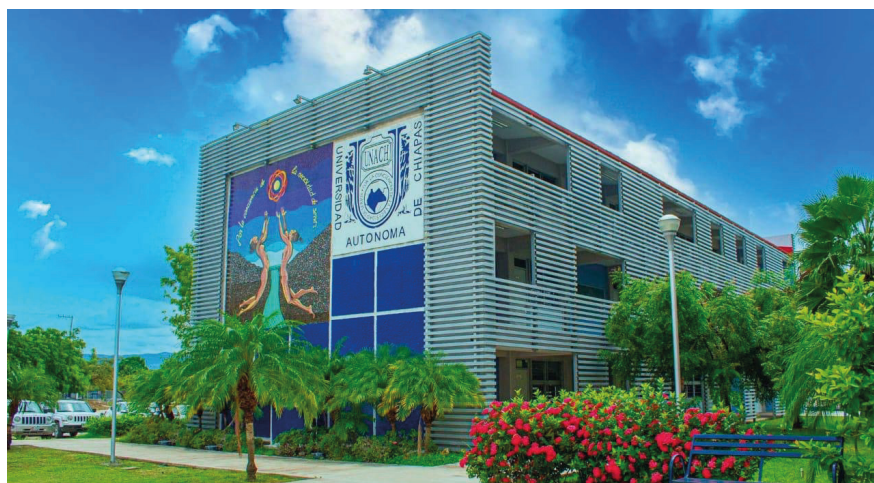
Edificio de Ciudad Universitaria
